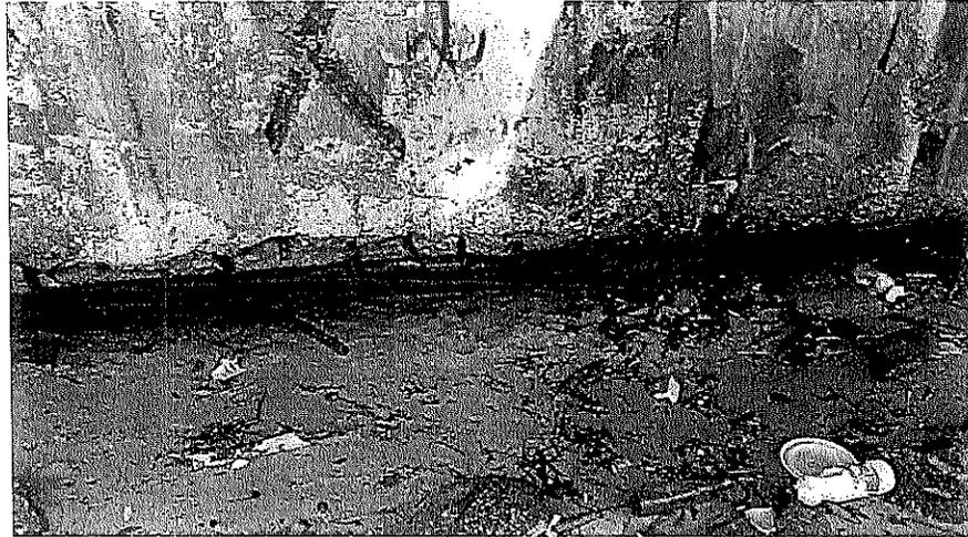
Foto 05 – Armadura principal inferior de flexão totalmente partida pelo processo corrosivo e sem o confinamento dos estribos, que também estão partidos.
