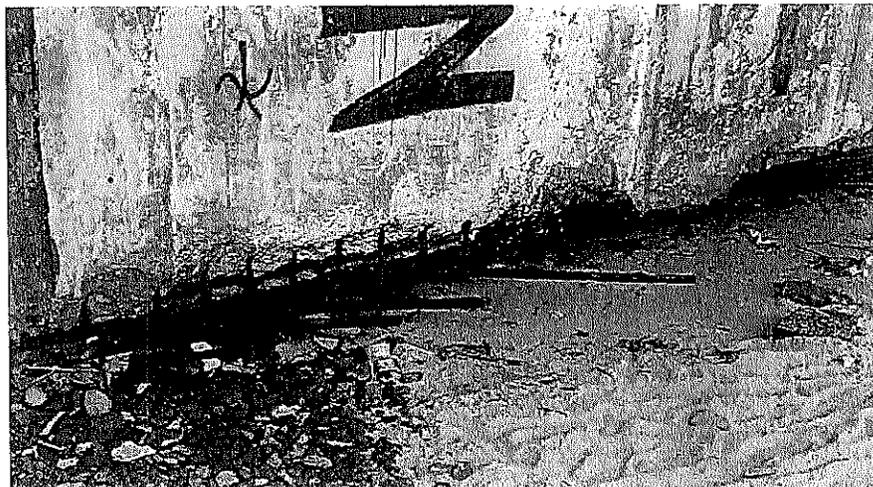
Foto 04 – Armadura principal inferior de flexão totalmente partida pelo processo corrosivo e sem o confinamento dos estribos, que também estão partidos.
